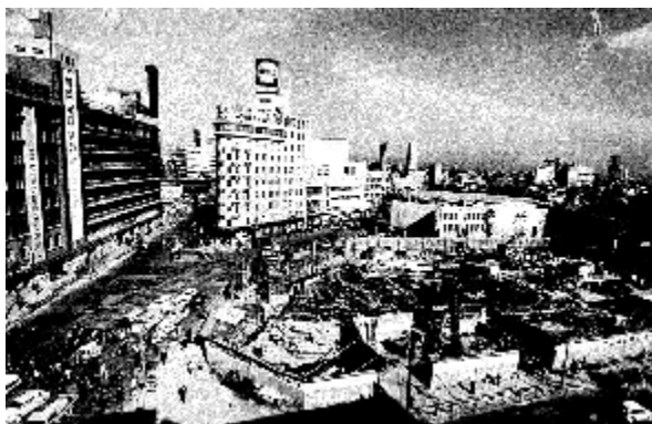
(写真提供 大阪地下街株式会社)
