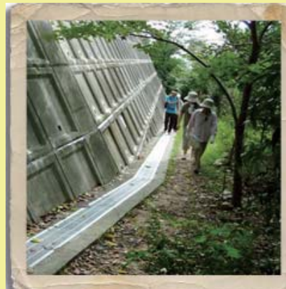
「ゆずり葉散策路」の園路にグレーチングを設置しました!!
